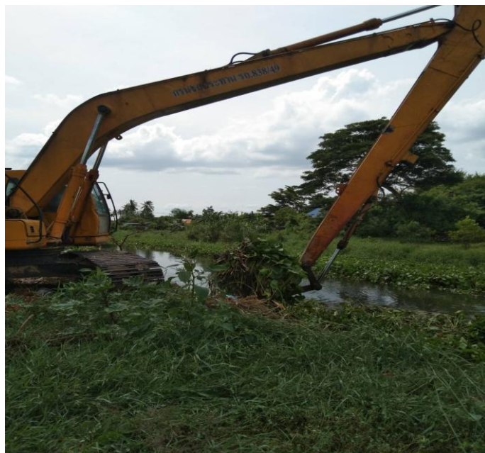
รูปการขุดลอกกำจัดผักตบชวาภายในคลองระบายน้ำ ๑ ซ้ายเจริญบุชา ตำบลทุ่งน้อย อำเภอเมืองนครปฐม จังหวัดนครปฐม ระหว่างดำเนินงาน
